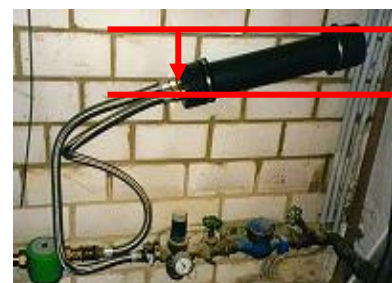
Schräg gestellte Montage ist möglich, jedoch immer Anschlüsse nach unten
